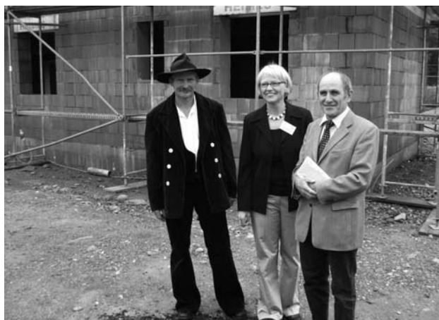
Zimmerer Christoph Schneider, Ingrid Hamel-Weber und Bürgermeister Alfons Heimes vor dem Rohbau des „Kastanienhofs“
